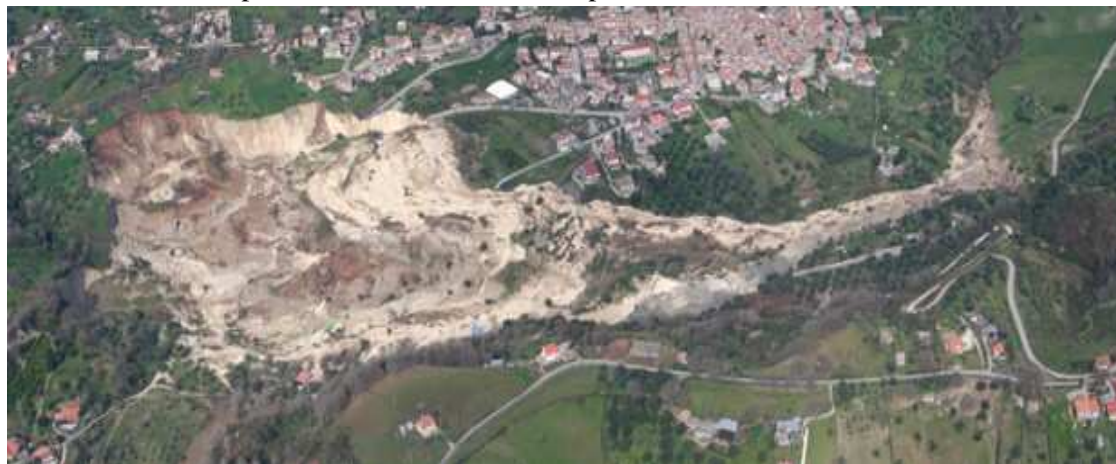
Figura 6.7 L'area interessata dalla frana del 15.2.2010 a Maierato (VV) Fonte: Protezione Civile.
